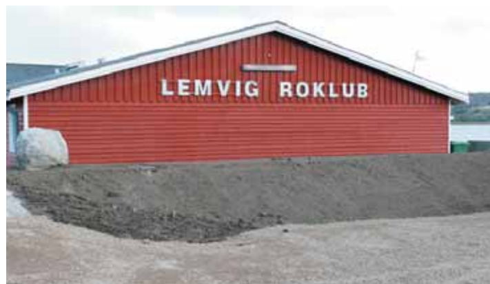
Det nye højvandsdige
